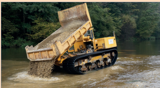
▲ Abb. 7: Einbau von Kieslaichplätzen im Unterwasser einer Wasserkraftanlage in einem bayerischen Huchenfluss. Fotos: C. Ratschan
