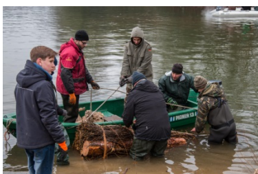
Befestigung des Totholzbündels am Motorboot
