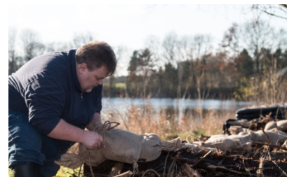
Befestigung der Säcke am Totholzbündel
