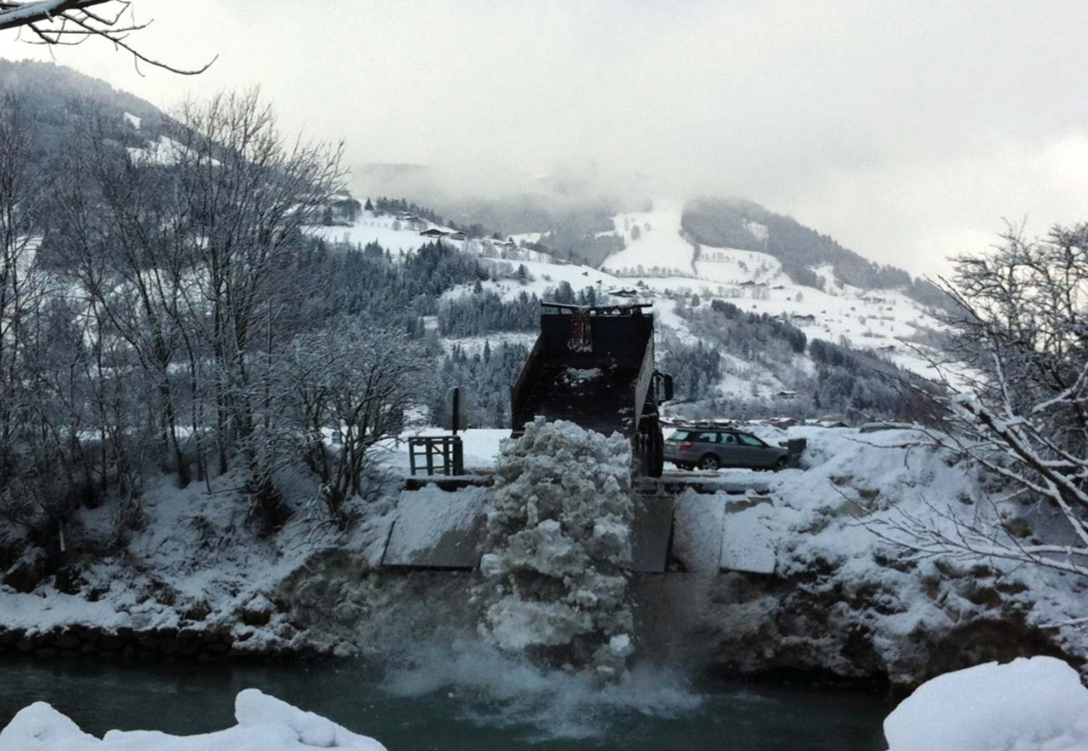
Räumschneeeinbringung über eine Rampe direkt in die fließende Welle.
