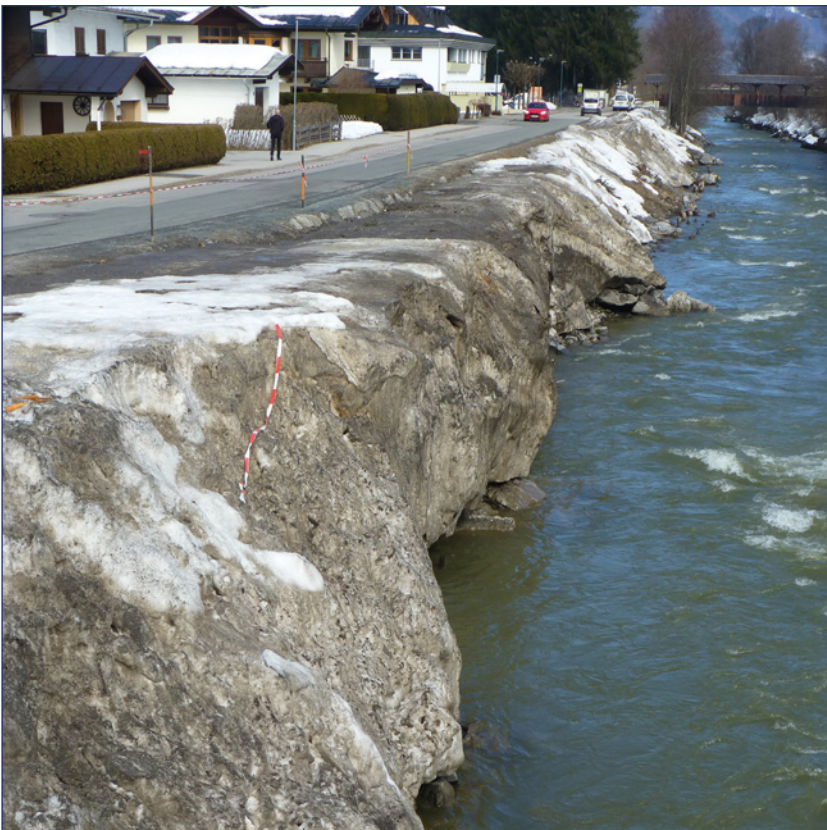
Stark verschmutzter Räumschnee am Ufer der Kitzbüheler Ache. Durch das Tauwetter drohten die abrutschenden Schneemassen die Ache stark zu belasten.
